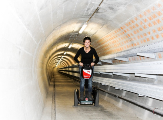
Fahrt durch den langen Eingangsstollen
