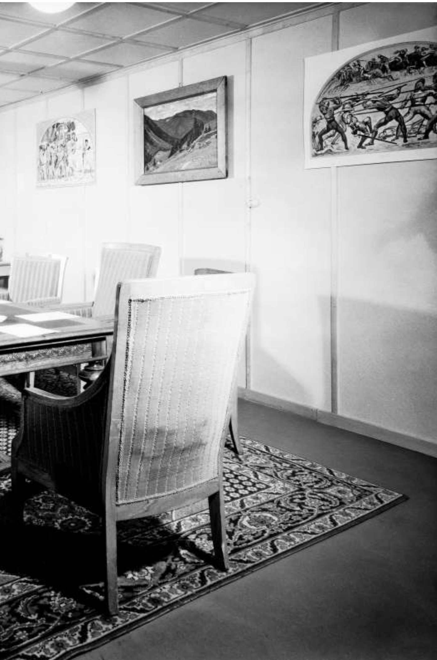
die unterirdische Anlage bezugsbereit war.
