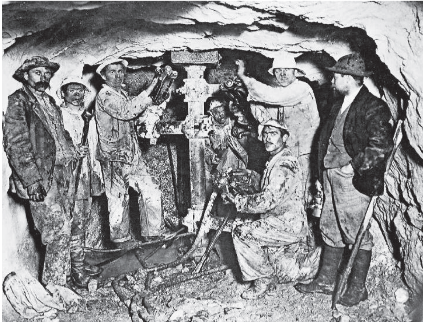
Gebaut wurde die unterirdische Schweiz von Einwanderern. Hier beim Bau des Lötschbergtunnels 1912.
